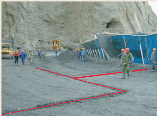
Installation eines Glasfaserkabels in der Walzbeton-Bogenstaumauer Shimenzhi, VR China
