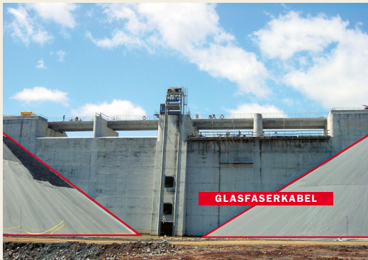
Midlands Dam, Mauritius Überwachung des Dichtungsanschlusses (Heat-Pulse-Methode)
