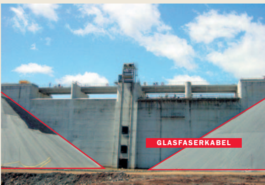
Midlands Dam, Mauritius Überwachung des Dichtungsanschlusses (Heat-Pulse-Methode)
