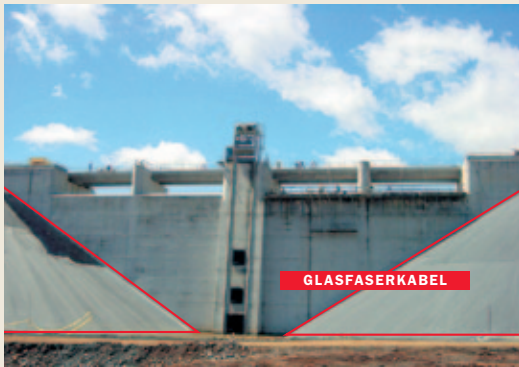
Midlands Dam, Mauritius Überwachung des Dichtungsanschlusses (Heat-Pulse-Methode)
