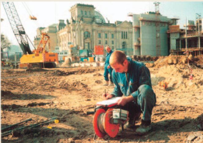
Thermische Lekdetektie in een bouwput in Berlijn
