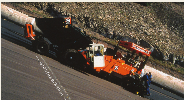
Installation eines Hybrid-Glasfaserkabels in der Asphalt-Oberfächendichtung der Ohratalsperre in Thüringen. Hier wird die Heat-Pulse-Methode zur Leckortung eingesetzt
