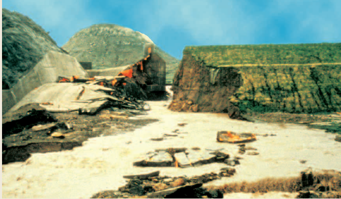
Zerstörung eines Dammes in Lesotho durch innere Erosion am Übergang zwischen Erddamm und Hochwasserentlastungsanlage.
