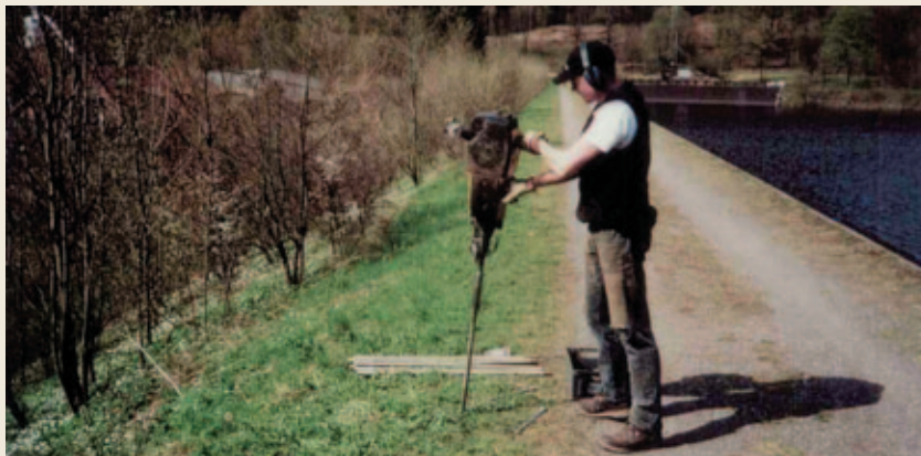
Einrammen der Temperatursondierröhrer in einen Damm
