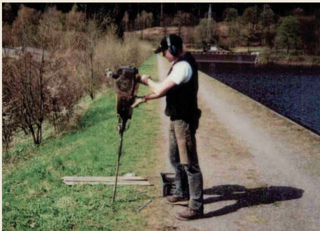
Einrammen der Temperatursondiergestänge in einen Damm
